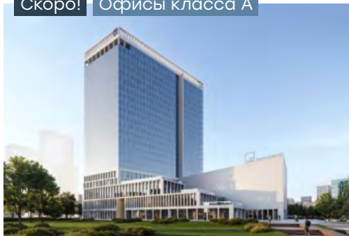
Level work Воронцовская
