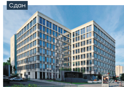
Бизнес-центр «Уолл Стрит»
