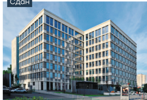
Бизнес-центр «Уолл Стрит»
