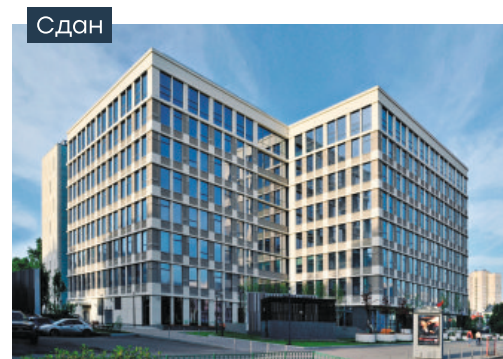
Бизнес-центр «Уолл Стрит»
