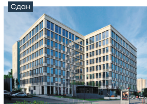
Бизнес-центр «Уолл Стрит»
