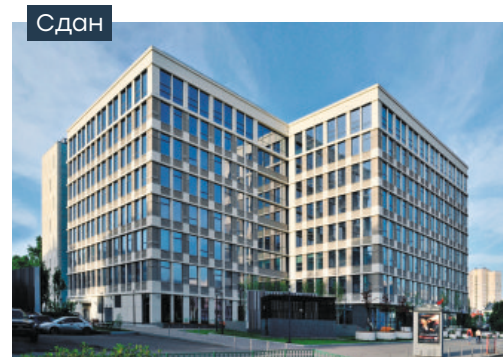
Бизнес-центр «Уолл Стрит»
