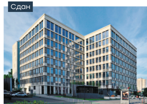
Бизнес-центр «Уолл Стрит»
