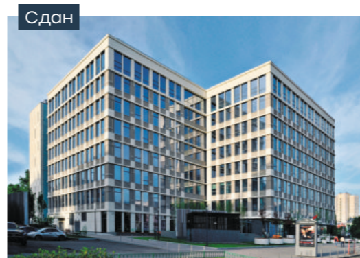
Бизнес-центр «Уолл Стрит»
