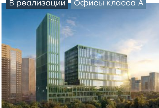
Level work Нижегородская
