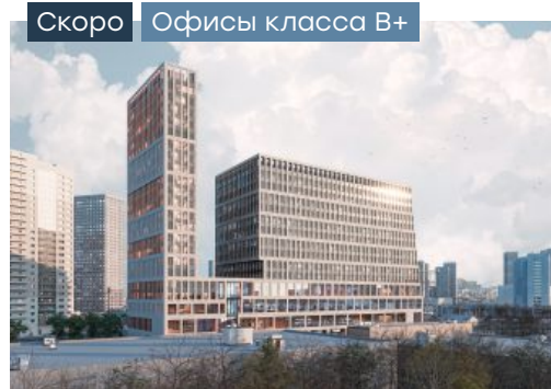
Level work Нижегородская
