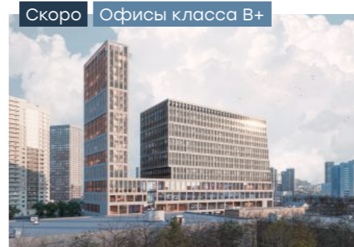
Level work Нижегородская
