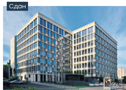
Бизнес-центр «Уолл Стрит»
