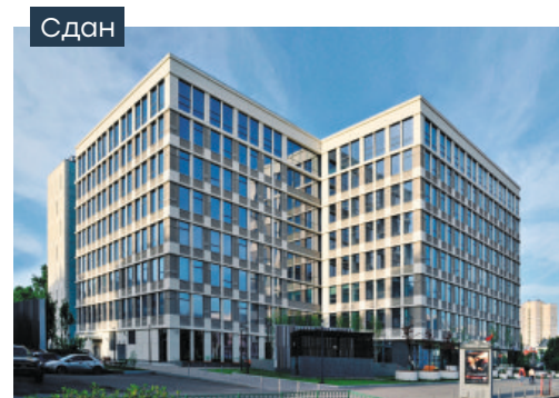
Бизнес-центр «Уолл Стрит»
