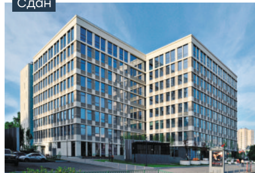
Бизнес-центр «Уолл Стрит»
