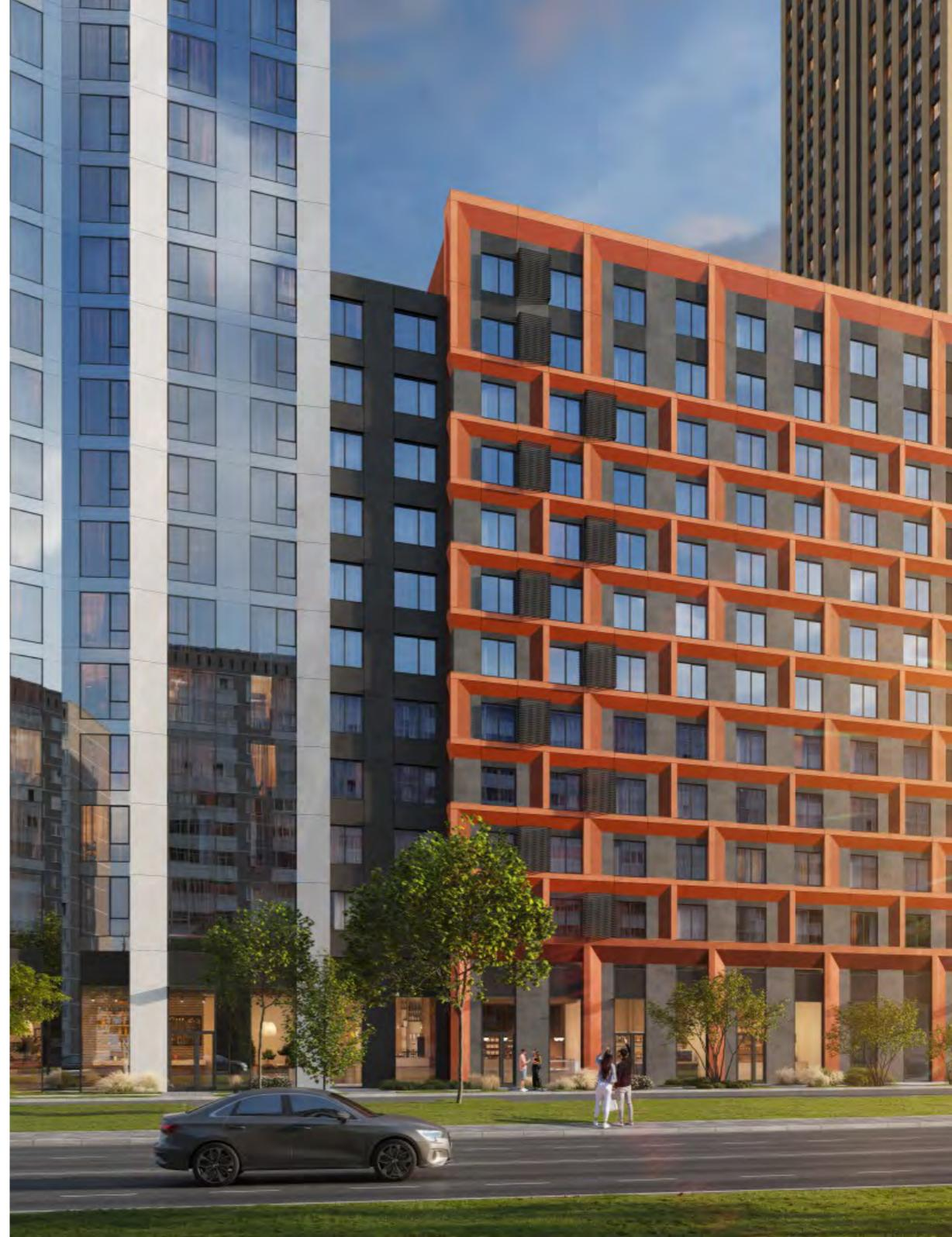
Для корпусов 11–13 мы выбрали навесную фасадную систему. Такие фасады обладают отличной звуко- и теплоизоляцией. Корпуса 11 и 12 будут облицованы панелями из алюминиевого композита, а для корпуса 13 мы используем фиброцементные панели, дополненные зеркальными металлическими кассетами.
