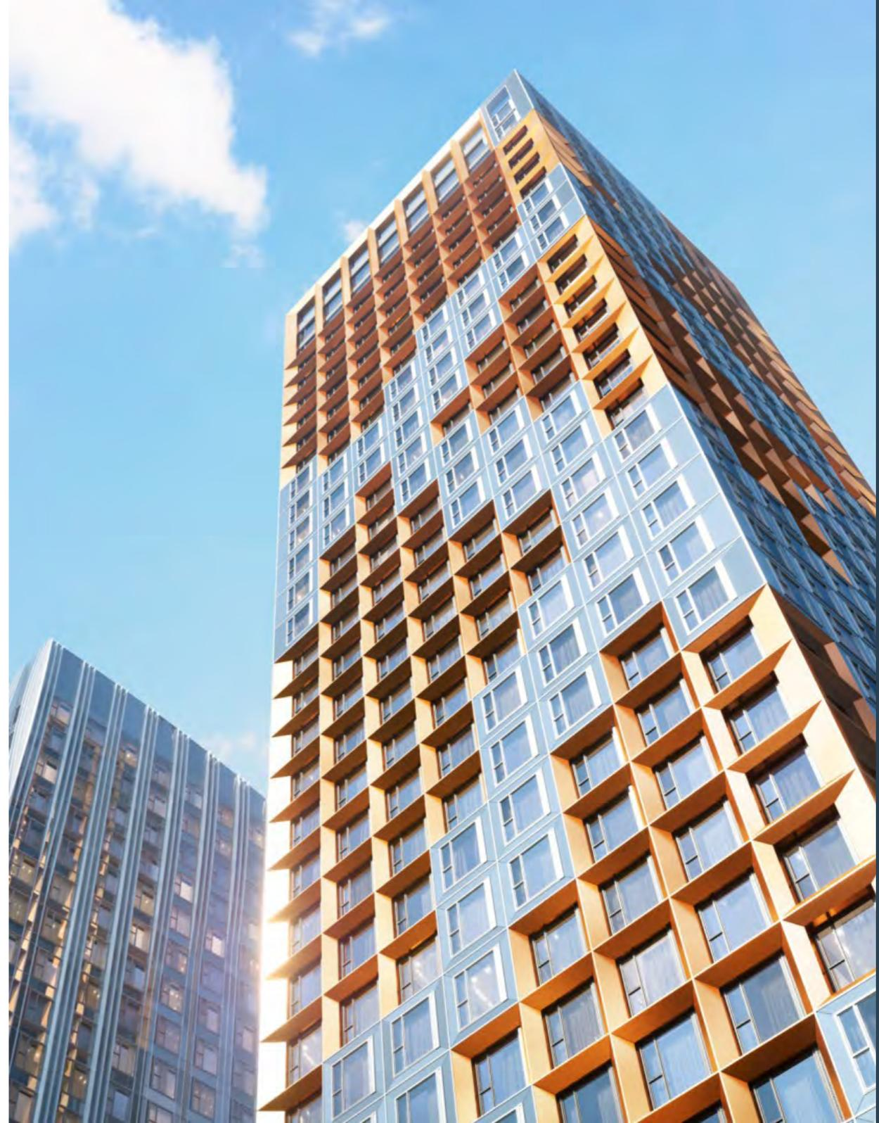
Для разновысотных корпусов 1–5 мы используем модульное остекление с интеграцией трёхмерных алюминиевых кассет. Эффектно меняя оттенок в зависимости от освещения и погоды, они зададут визуальную динамику всего района.
