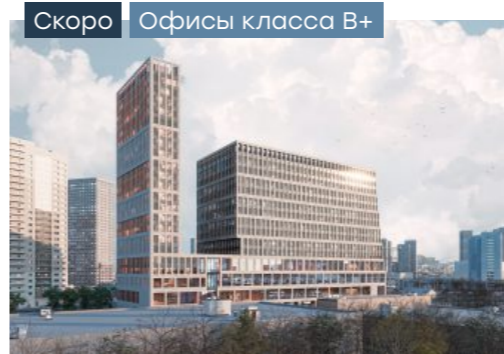
Level work Нижегородская
